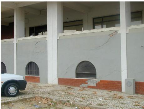
Fig. 3 – Fissuração em paredes com origem estrutural.
