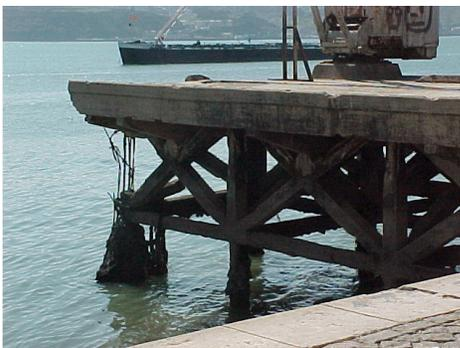
Fig. 5 – Colapso de pilar, com origem na corrosão de armaduras.
