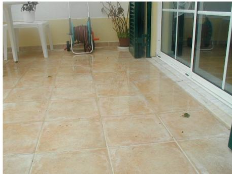
Fig. 2 – Pavimento com pendente deficiente.
