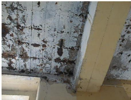
Fig. 4 – Fissuras e delaminação no betão devido a corrosão das armaduras.
